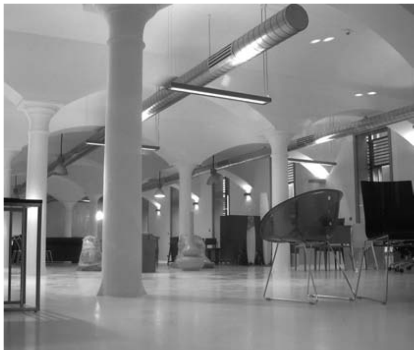
Obr. 4 – Originální sloupky v projekčním ateliéru v prvním podlaží
